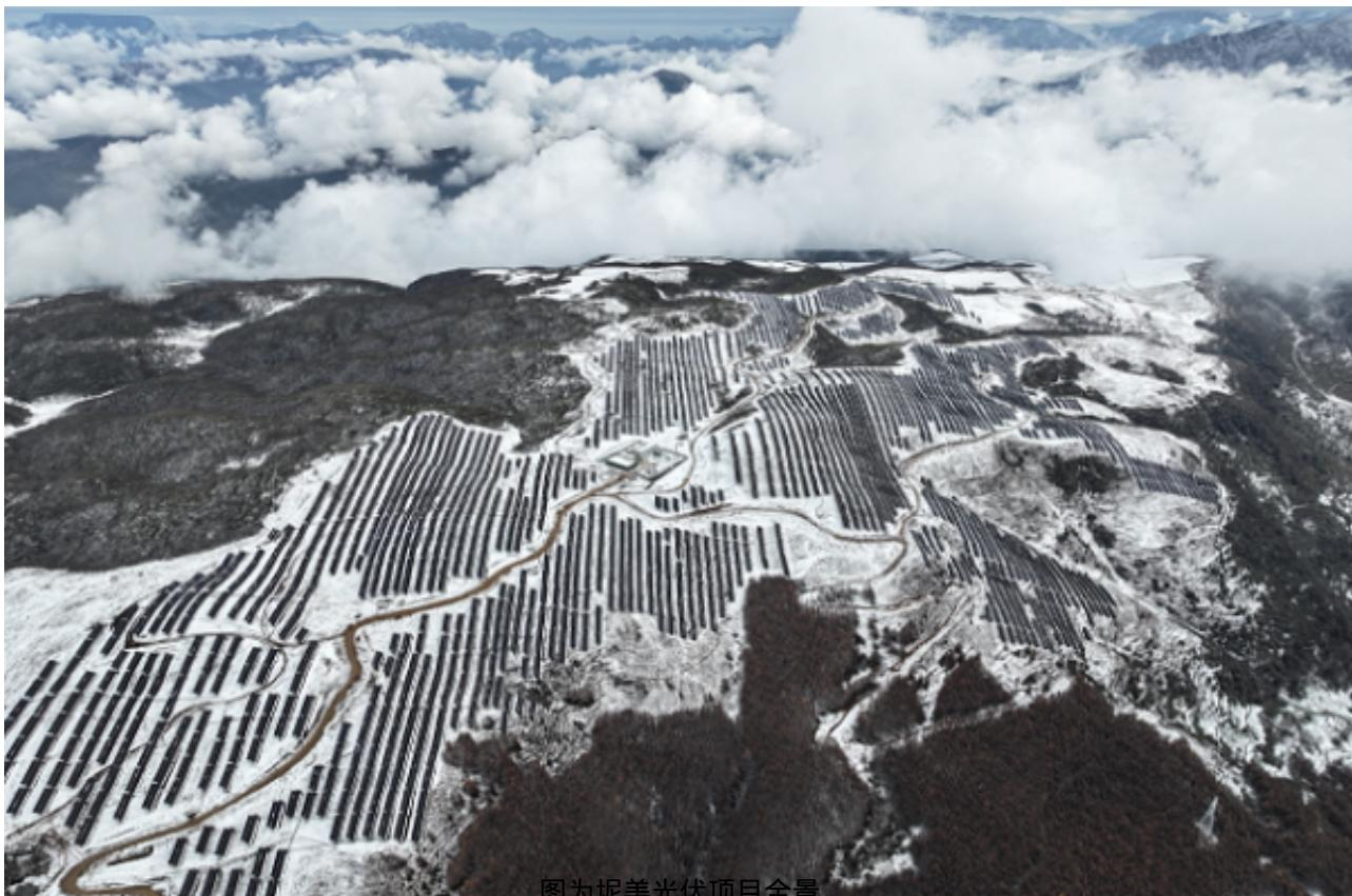
尼美光伏电站位于四川省汉源县尼美乡境内，为瀑布沟水电站水风光互补项目——汉源400兆瓦光伏项目之一。电站平均海拔在2200至2600米之间，总装机容量为70兆瓦。项目全容量投产后，预计年发电量可达1亿千瓦时，可满足5万户家庭年用电需求，每年可减少二氧化碳排放约8万吨，具有显著的经济效益、社会效益，将成为推动地方经济高质量发展的关键动力。
